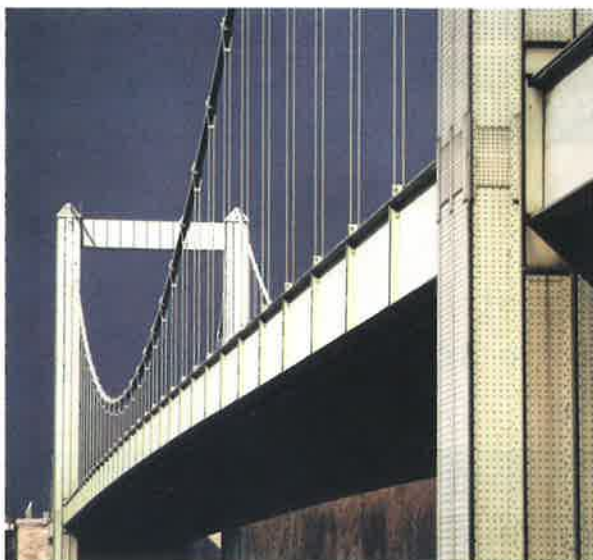
Il ponte di Rodenkirchen, disegnato da Fritz Leonhardt nel 1938.
