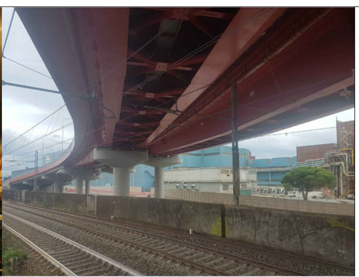
VIADOTTO STRADA A MARE GENOVA
