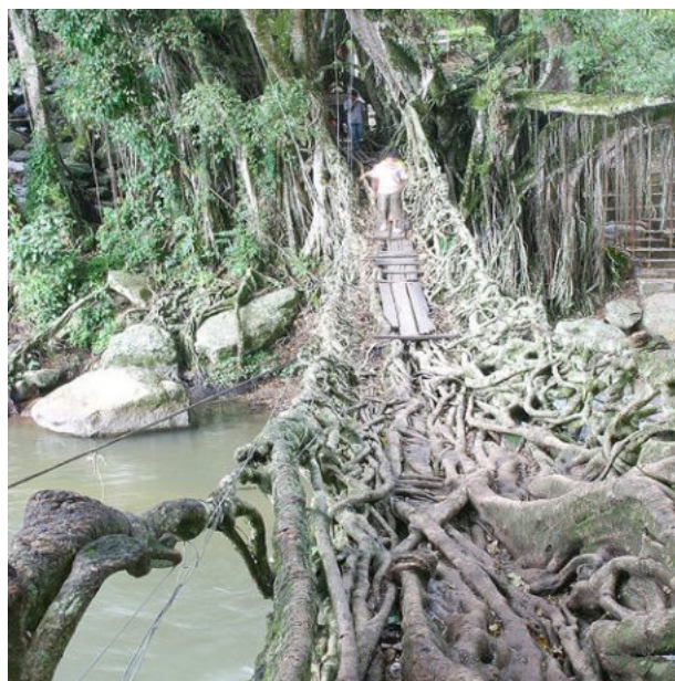
Fig. 3. Il Jembatan Akar Bridge
