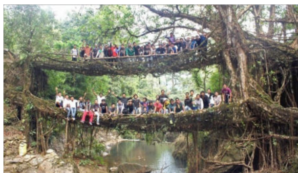
Fig. 2. Il ponte a due piani di Nongriat sul fiume Umshiang
