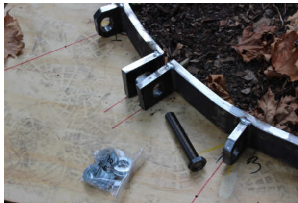
Particolare dei punti di unione tra flange continue mediante bullonatura (elementi accoppiati) e dei punti di attacco delle doppie bielle angolate per l'ancoraggio dei tiranti
