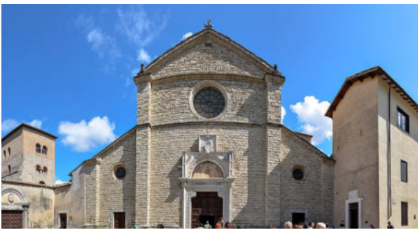
Fig. 7 - Farfa. Facciata della Chiesa dopo i restauri degli anni '80
