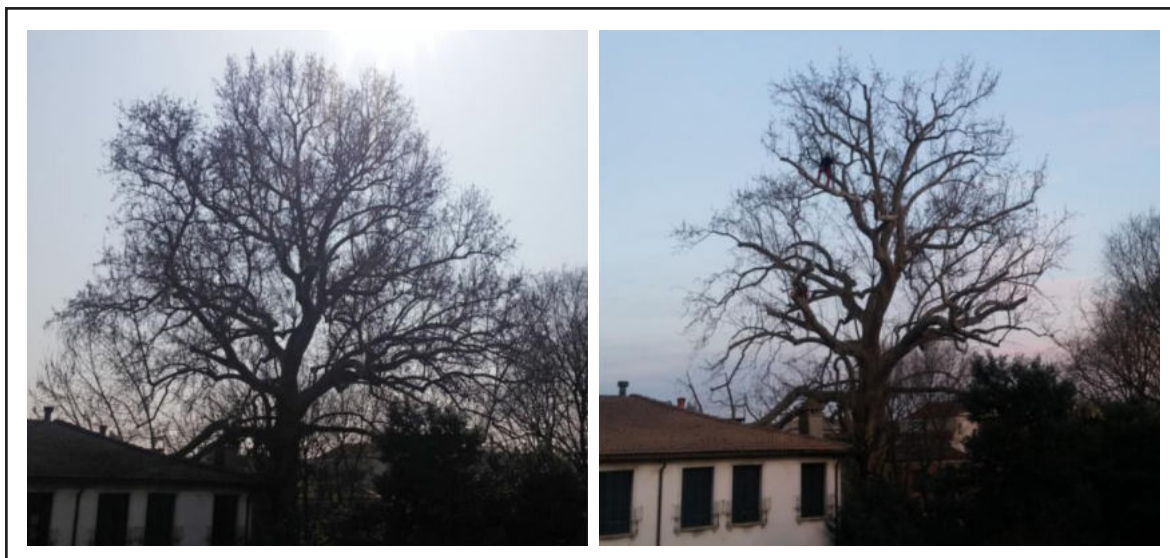
Immagini del platano pre e post potatura eseguita nel marzo 2015. Al ricontrollo del luglio 2016 il platano presentava questa conformazione della chioma (foto sotto)
