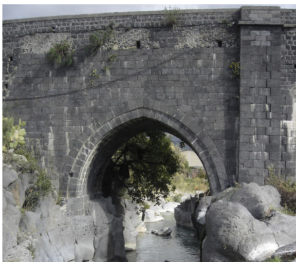
Ponte sull'Alcantara in territorio di Castiglione di Sicilia – Rimaneggiamento da ponte d'epoca
