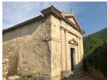
Fig. 28 Cittaducale. Chiesa di S. M. di Sesto. Facciata
