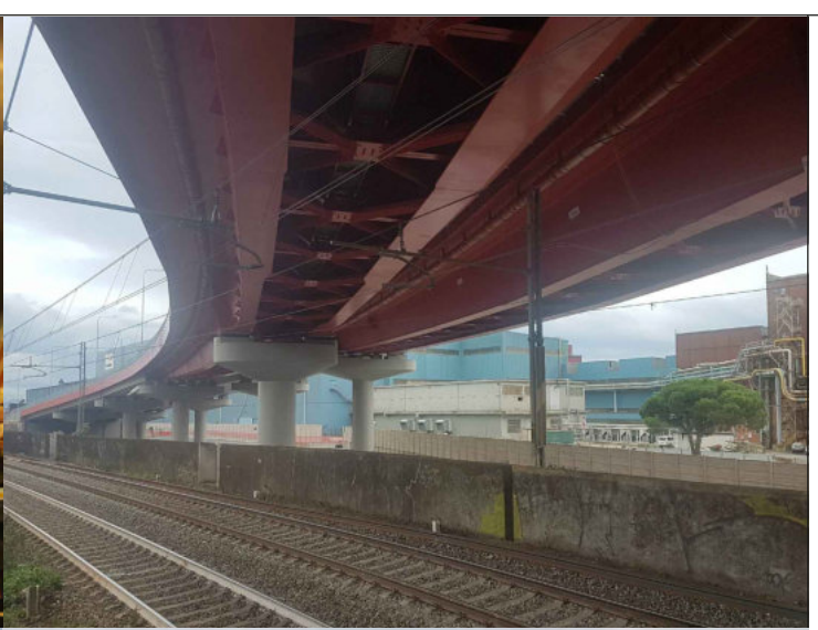
VIADOTTO STRADA A MARE GENOVA
