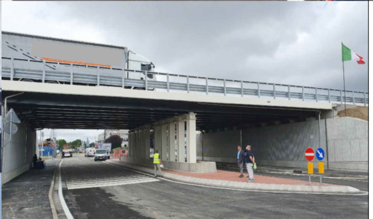
VIADOTTO TANGENZIALE EST PADOVA
