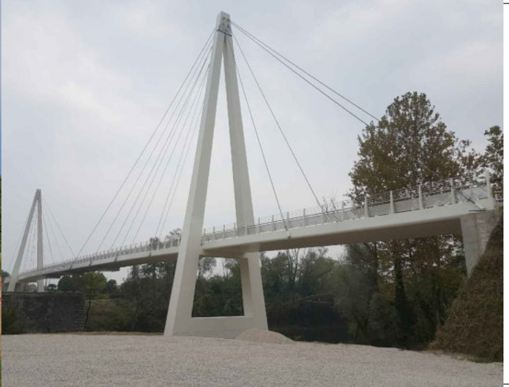
PASSERELLA STRALLATA SUL BRENTA
