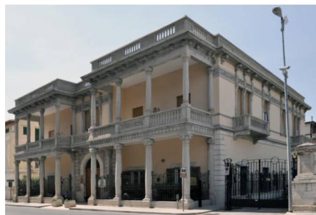
Fig. 9 - Corato. Casa Capano, fronte sulla via per Ruvo. Foto di Anna De Palma, 2017.
