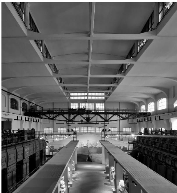
Fig. 5 - La sala macchine della Centrale Montemartini con le strutture in cemento armato realizzate dalla ditta Ing. H. Bollinger concessionaria del brevetto Baroni Lülting (2021).
