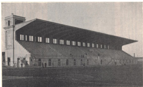
Fig. 10 - Bergamo La tribuna del campo sportivo (da L. Santarella, Il Cemento armato , Hoepli, Milano, 1957).
