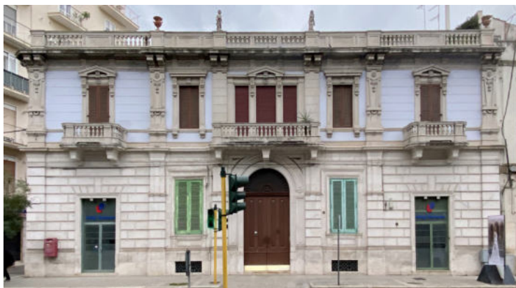
Fig. 14 - Corato. Palazzo Tedeschi, vista del fronte. Foto dell'A., 2023.
