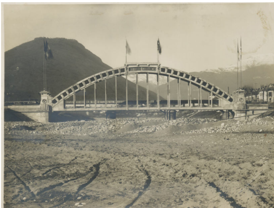
Fig. 11 - Intra. Ponte ferroviario in cemento armato "Vittorio Cobianchi" sul torrente S. Bernardino, 1928 (demolito nel 1961), fotografia d'epoca. Archivio Santarella Milano, per gentile concessione.
