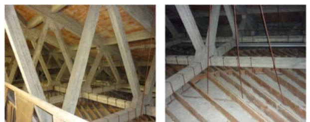
Fig. 6 - Adria. Teatro Comunale, viste della struttura di copertura. Foto dell'A., 2014.
