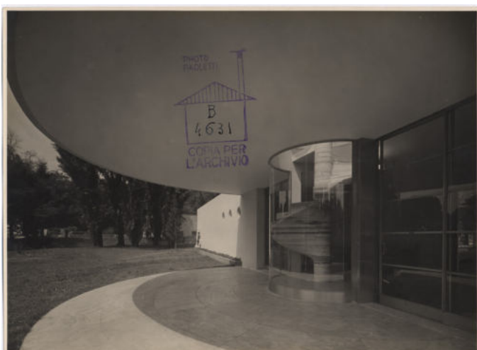
Fig. 3 - Milano. Casa del sabato per gli sposi, pensilina a sbalzo. Foto Paoletti (Milano, 1933). Fondazione Piero Portaluppi, Milano, per gentile concessione.
