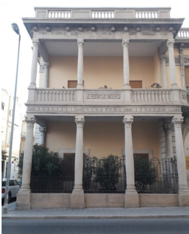
Fig. 11 - Corato. Casa del Sig. Antonio Capano, 1913, dettaglio dell'ordine architettonico. Foto dell'A., 2023.
