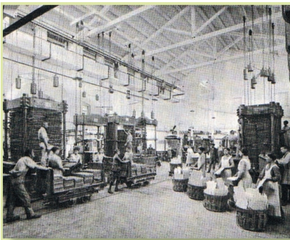
Un reparto di lavorazione della Mira-Lanza
