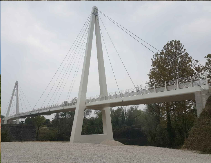
PASSERELLA STRALLATA SUL BRENTA
