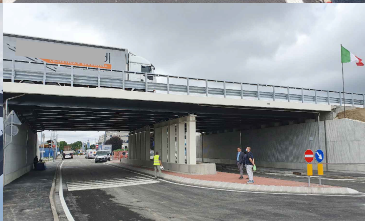
VIADOTTO TANGENZIALE EST PADOVA
