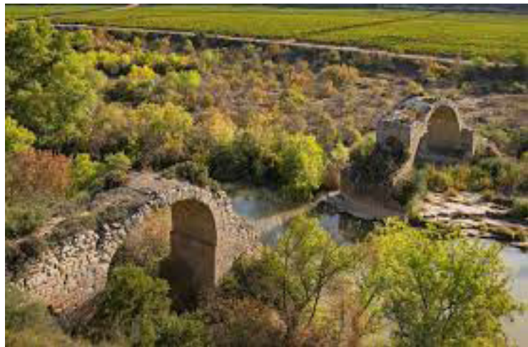
Fig. 12 - Il ponte romano di Mantible (prima metà II secolo)
