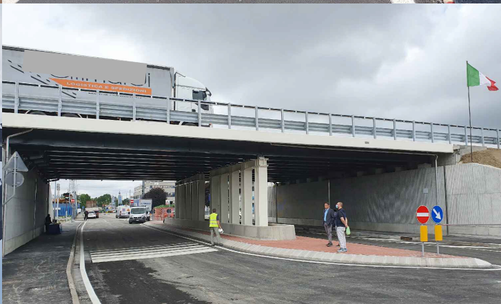
VIADOTTO TANGENZIALE EST PADOVA
