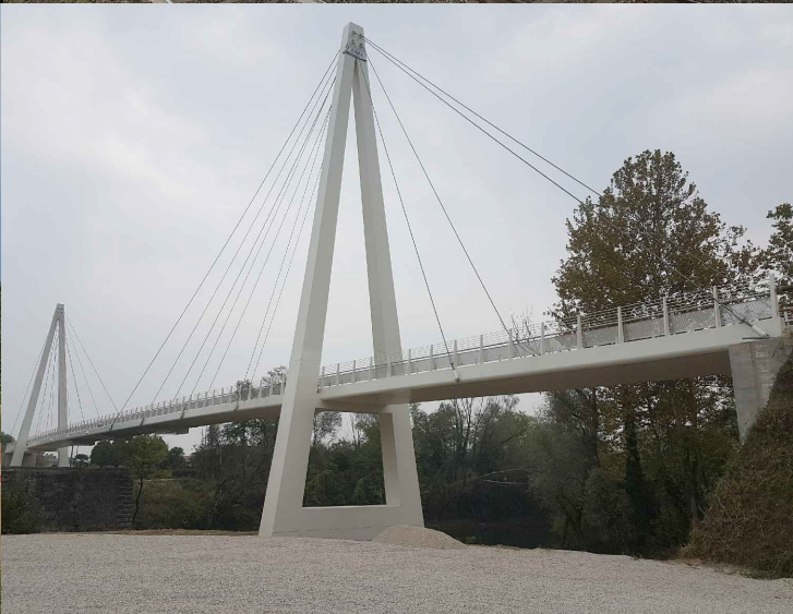
PASSERELLA STRALLATA SUL BRENTA
