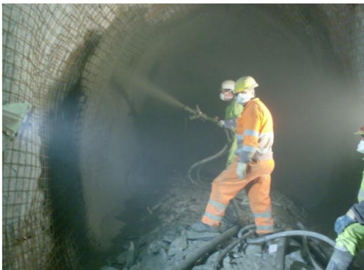
Fig. 3 – Proiezione automatizzata del calcestruzzo
