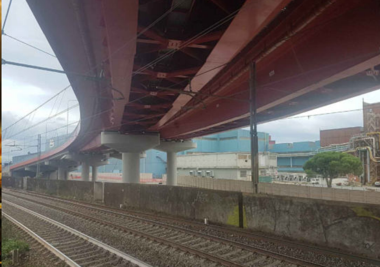
VIADOTTO STRADA A MARE GENOVA
