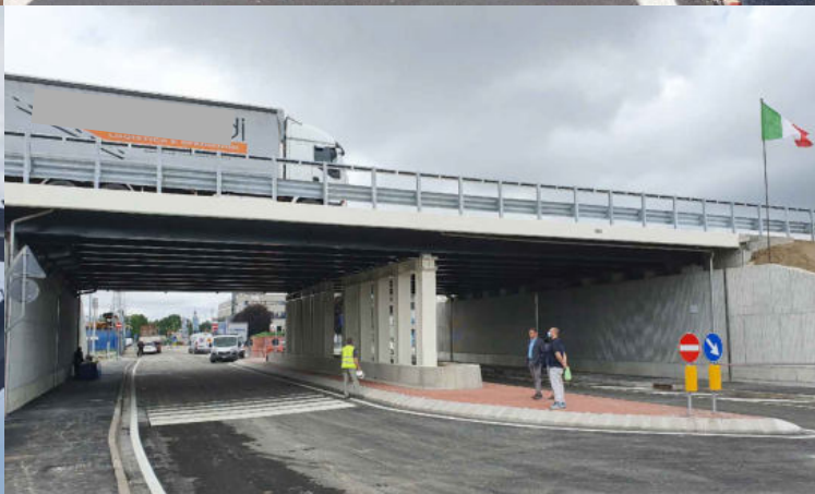
VIADOTTO TANGENZIALE EST PADOVA
