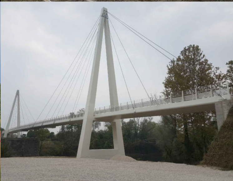
PASSERELLA STRALLATA SUL BRENTA
