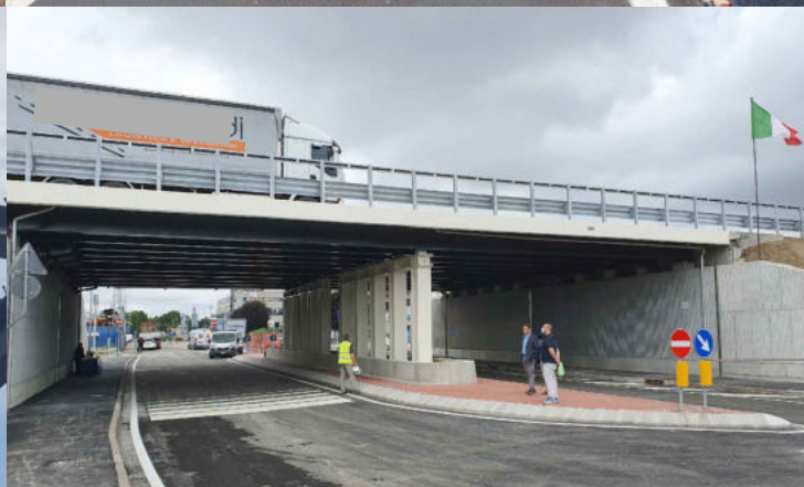
VIADOTTO TANGENZIALE EST PADOVA
