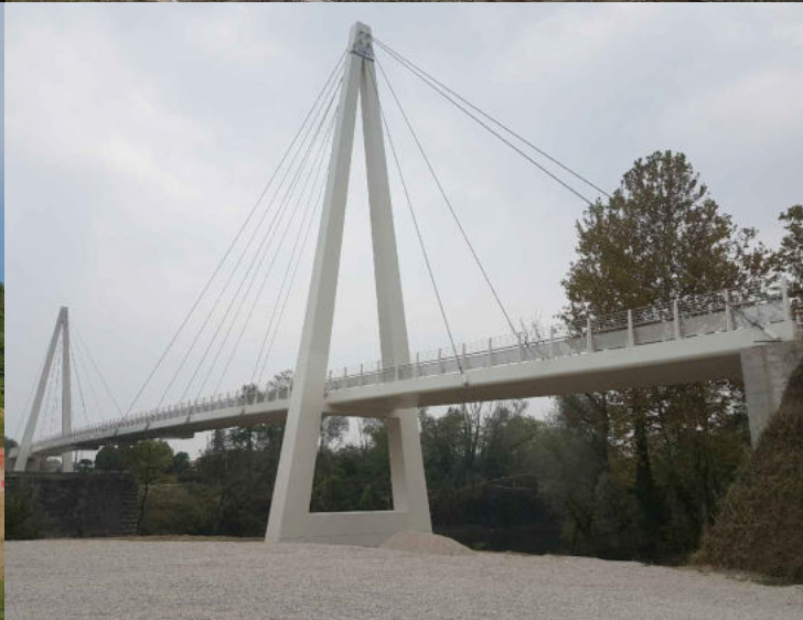
PASSERELLA STRALLATA SUL BRENTA
