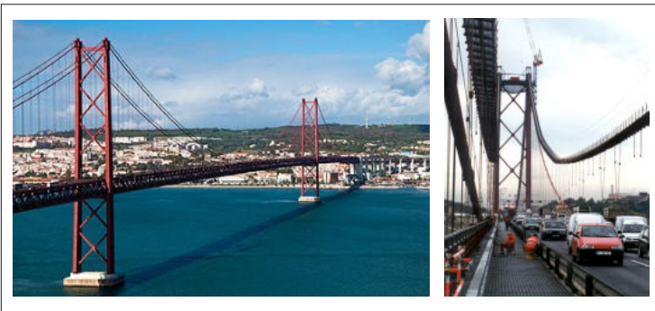
Fig. 13 - I doppi cavi sovrapposti del Ponte 25 de Abril
