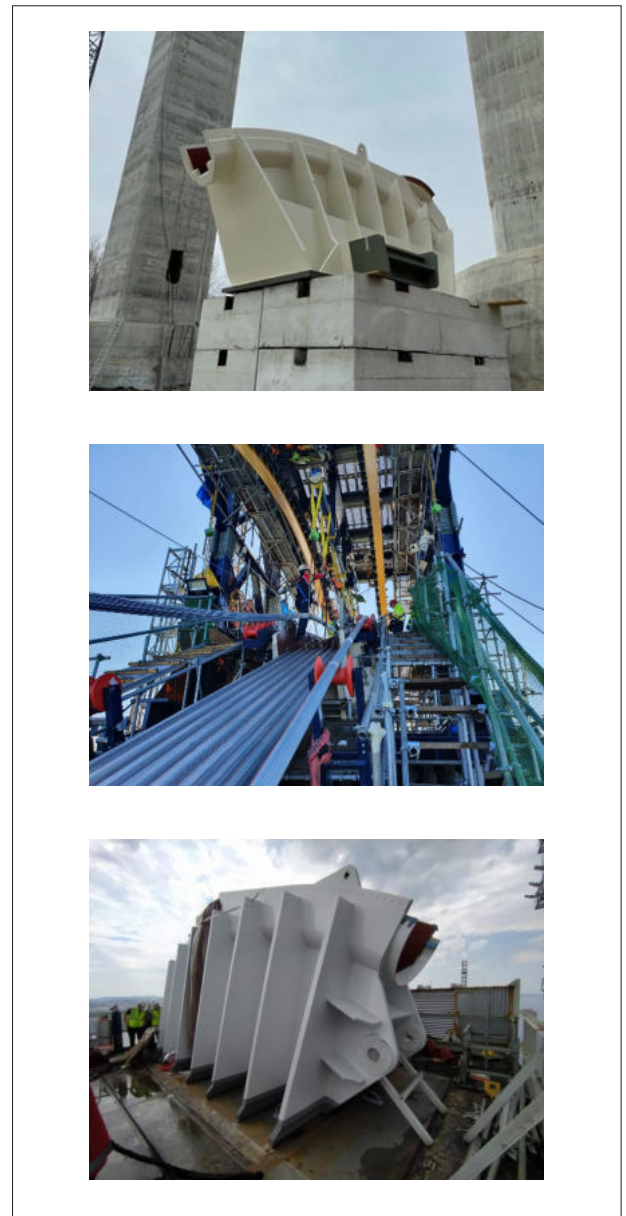
Fig. 19 - Selle di sommità delle torri: prima in alto il Ponte sul Danubio a Braila, in basso il Ponte “1915”
