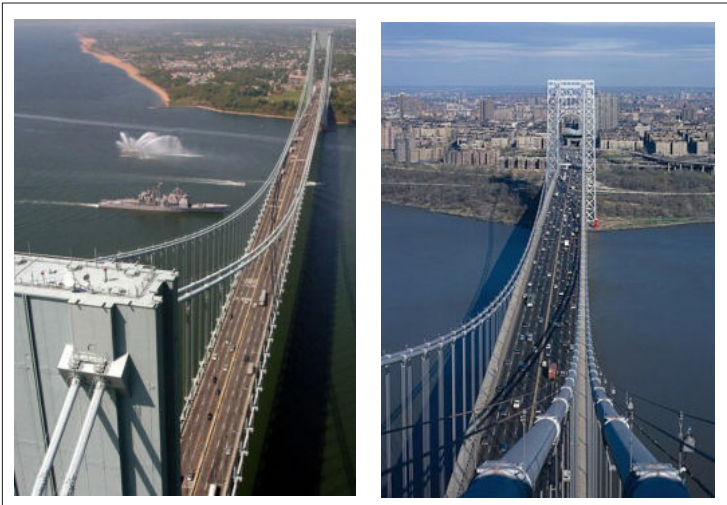
Fig. 12 - a sinistra I cavi gemelli del Ponte George Washington; a destra I cavi gemelli del Ponte Giovanni Da Verrazzano
