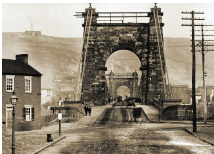
Fig. 11 - In alto i Cavi del Ponte di Tournon et Tain, 1825; sotto il Ponte di Wheeling, 1849
