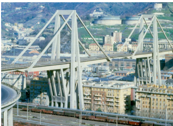
Fig. 11 - Il ponte sul Polcevera a Genova
