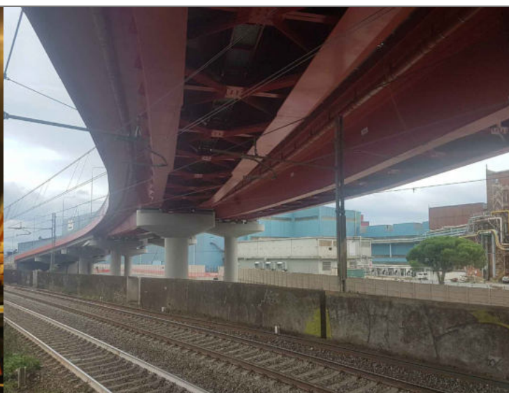
VIADOTTO STRADA A MARE GENOVA
