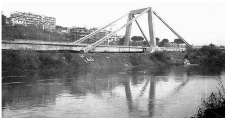
Fig. 14 - Viadotto sull'ansa del Tevere alla Magliana a Roma
