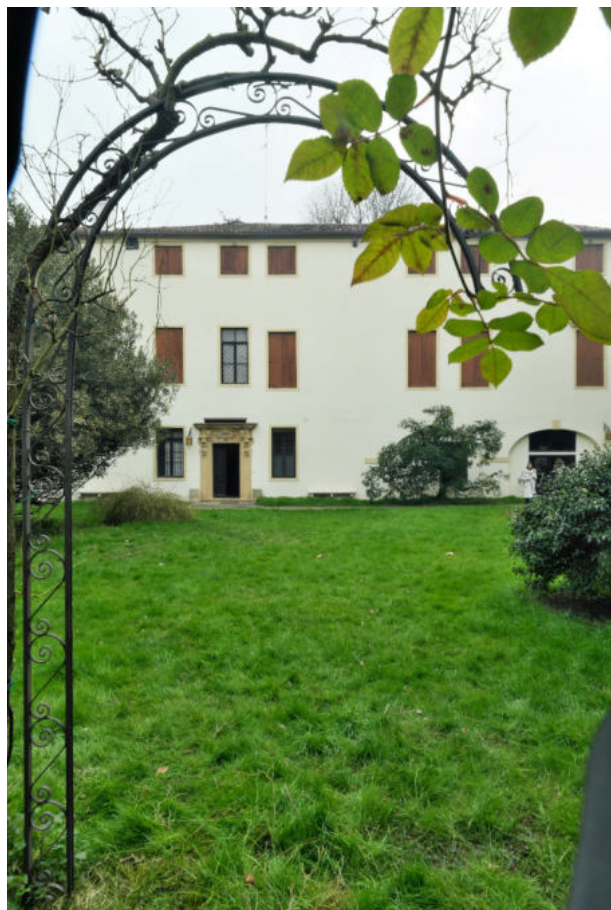
Fig. 3 - L'ala interna del Palazzo Conti prospiciente il giardino
