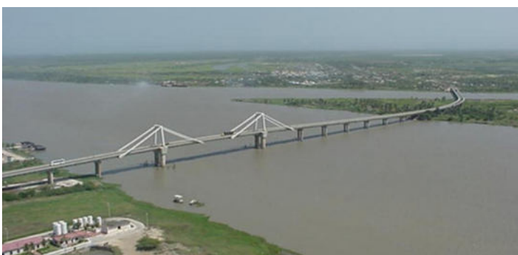
Fig. 4 - ponte a Baranquilla, Bolivia
