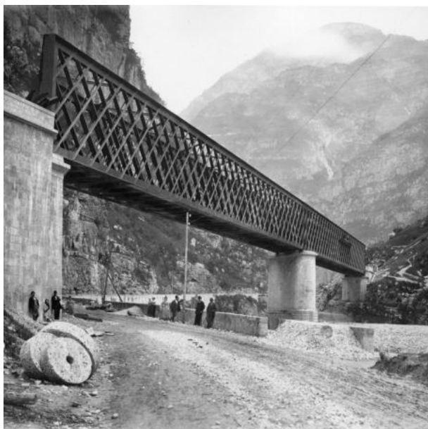
Fig. 4 - G.B. Biadego, Ponte sul fiume Fella, Chiusaforte, Udine, 1878-1879
