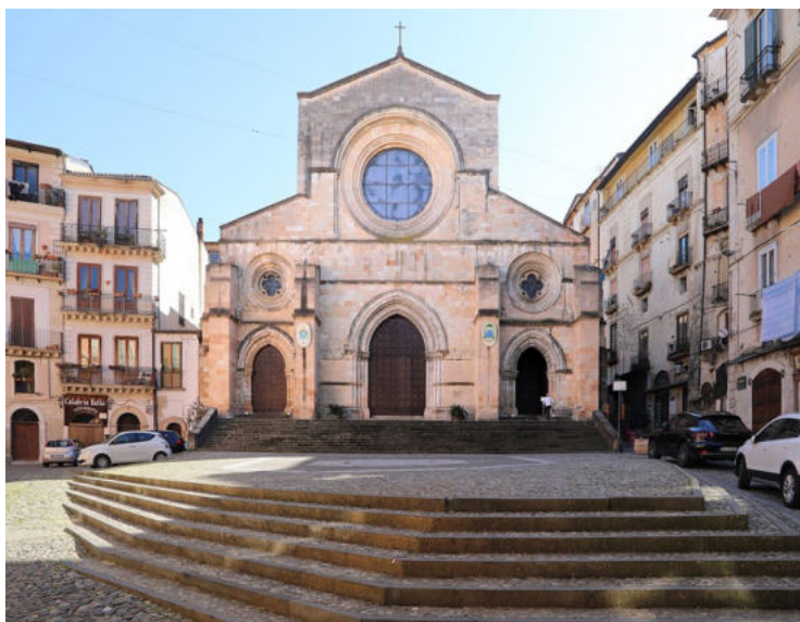
Fig. 1. Duomo di Cosenza, facciata principale a salienti con tre portali d'accesso
