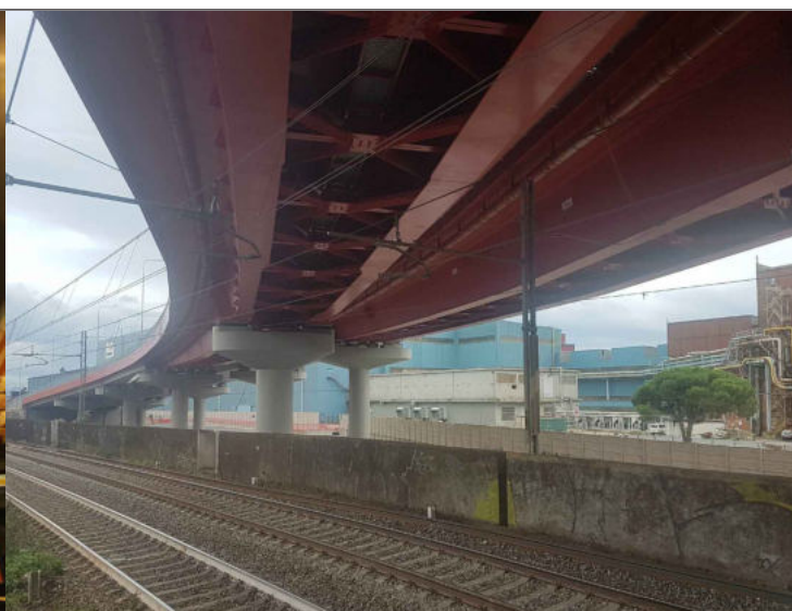
VIADOTTO STRADA A MARE GENOVA
