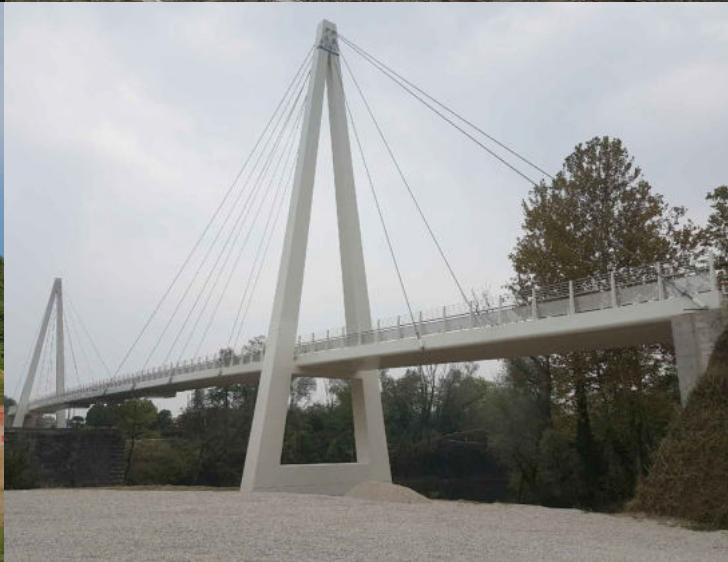
PASSERELLA STRALLATA SUL BRENTA
