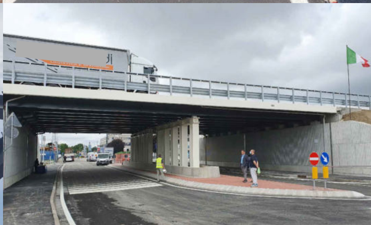
VIADOTTO TANGENZIALE EST PADOVA
