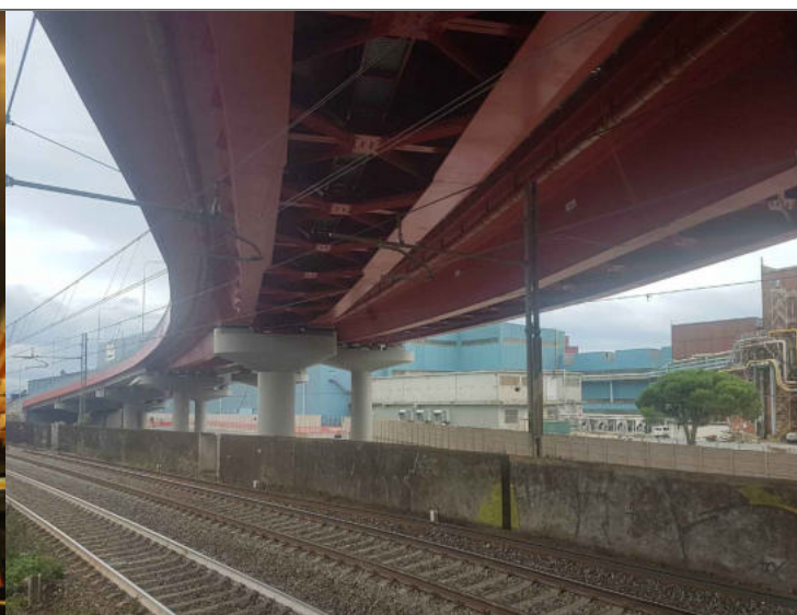
VIADOTTO STRADA A MARE GENOVA
