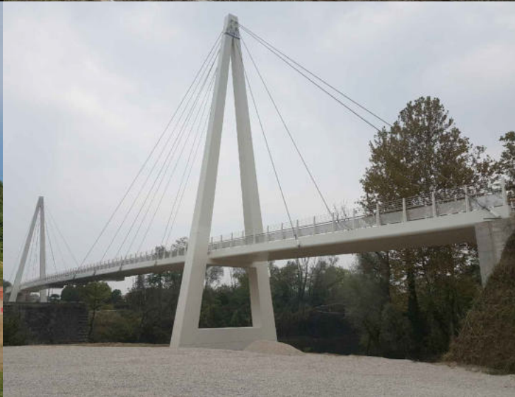
PASSERELLA STRALLATA SUL BRENTA
