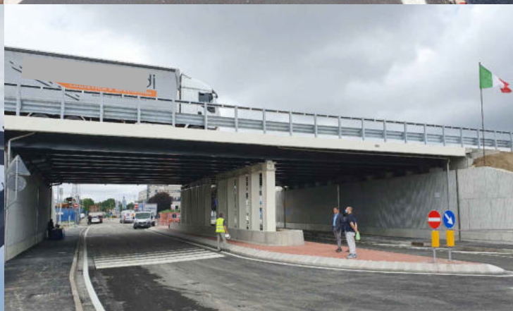
VIADOTTO TANGENZIALE EST PADOVA
