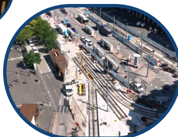
Cantiere delle nuove linee del tram di Padova, 2025
