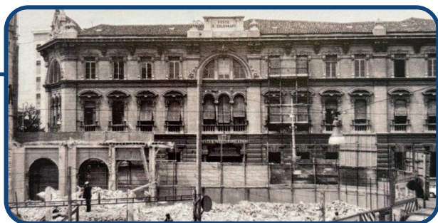
Cantiere in zona Eremitani
